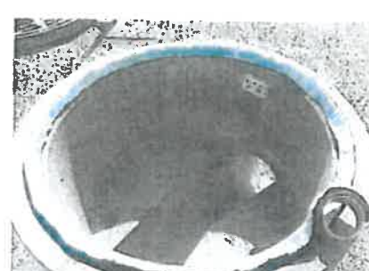
Etape 3 : Dérouler le joint en veillant qu'il soit toujours en contact avec la portée de joint.
