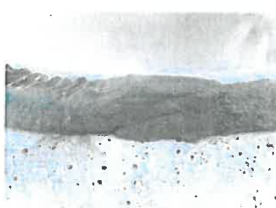
Etape 5 : Solidariser les parties de joint biseautées par légère pression.
