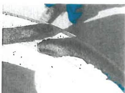
Etape 4 : Couper en biseau les 2 extrémités de joint.
